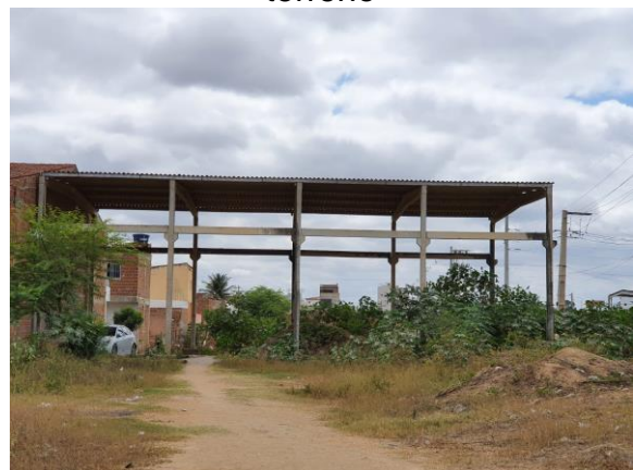
Figura 03: Vista lateral da estrutura no terreno
