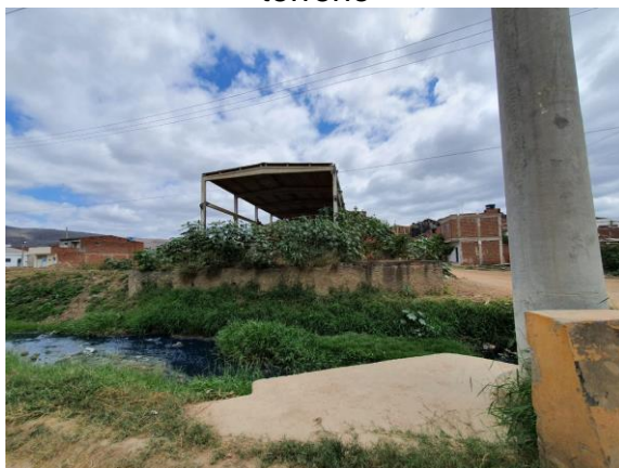
Figura 02: Vista frontal da estrutura no terreno
