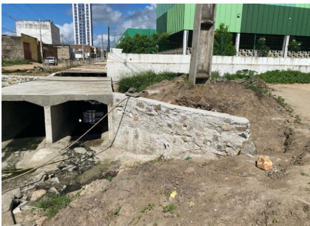
RUA PROJETADA S5Q18Q20 (BAIRRO DO ANTÃO) - BDCC - 03
