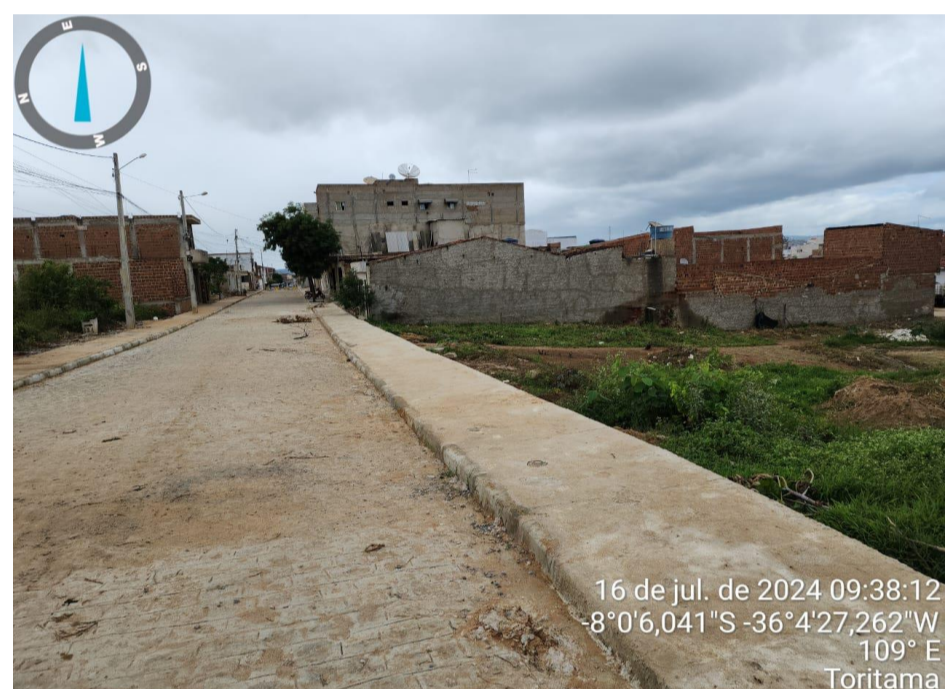
FOTO-02 - Pavimento e calçadas da Rua Everaldo Guedes
