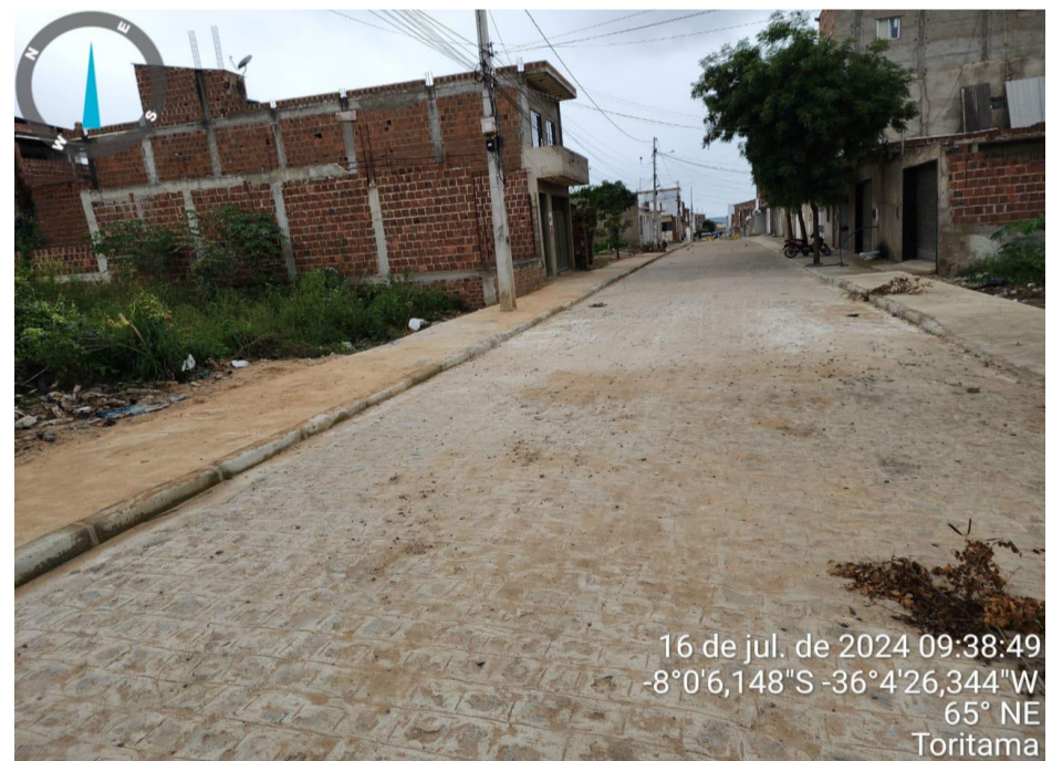
FOTO-04 - Pavimento e calçadas da Rua Everaldo Guedes
