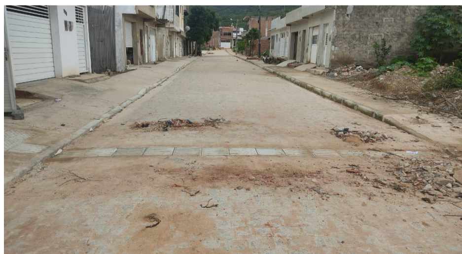
FOTO-09 - Pavimento e calçadas da Rua Everaldo Guedes
