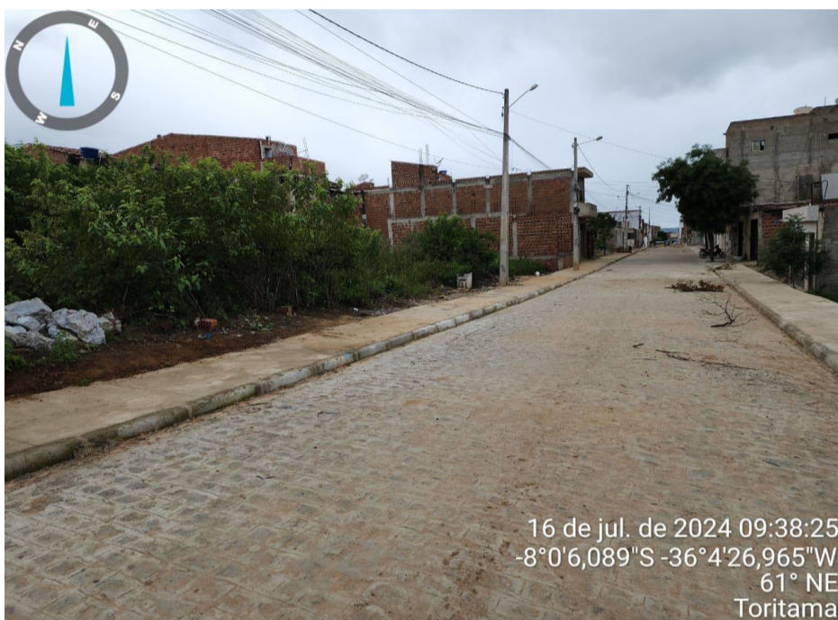
FOTO-01 - Pavimento e calçadas da Rua Everaldo Guedes
