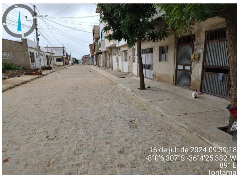
FOTO-05 - Pavimento e calçadas da Rua Everaldo Guedes
