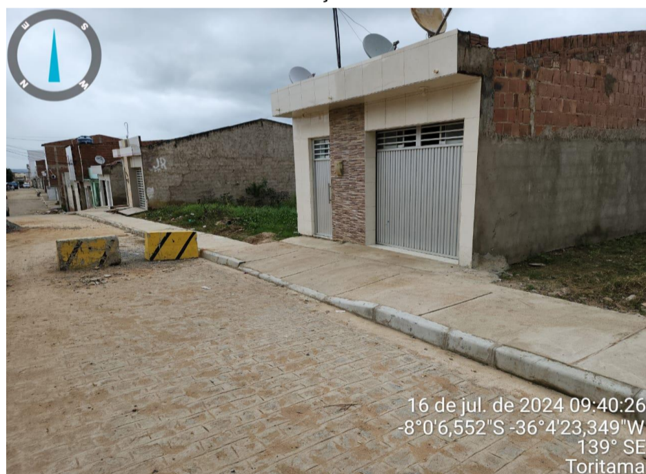
FOTO-08 - Pavimento e calçadas da Rua Everaldo Guedes
