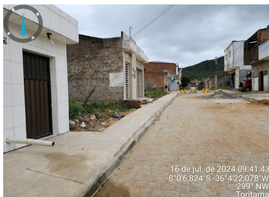
FOTO-06 - Pavimento e calçadas da Rua Everaldo Guedes
