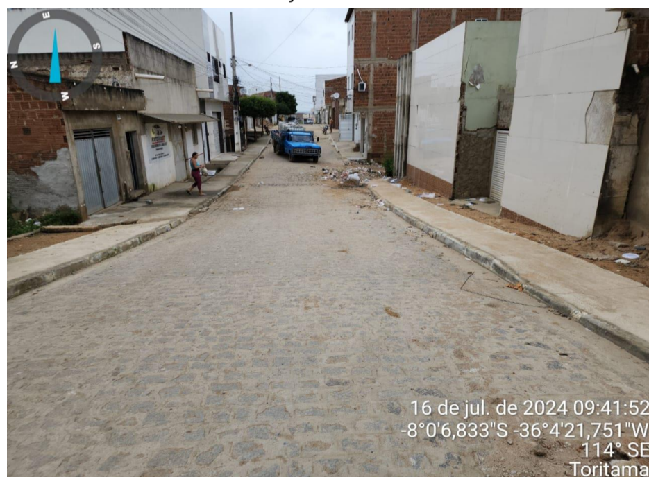
FOTO-07 - Pavimento e calçadas da Rua Everaldo Guedes
