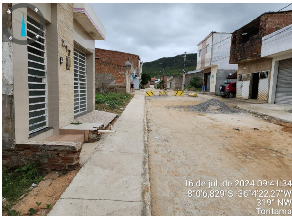
FOTO-03 - Pavimento e calçadas da Rua Everaldo Guedes
