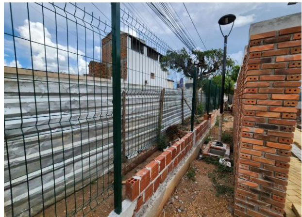
FOTO - 54 DIVERSOS GERAL - Gradil dos Fundos - Rua Jerônimo Celestino
