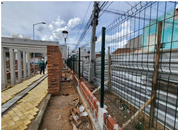
FOTO - 53 DIVERSOS GERAL - Gradil dos Fundos - Rua Jerônimo Celestino
