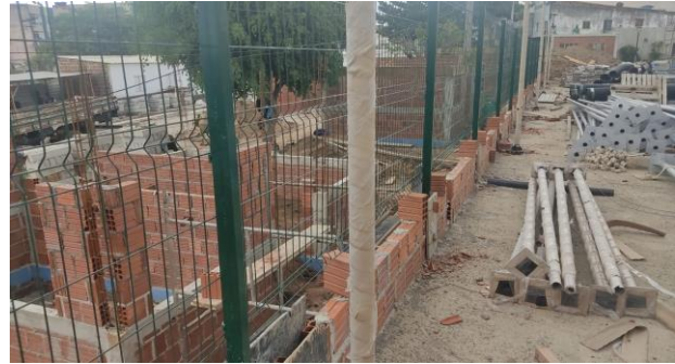
FOTO - 52 DIVERSOS GERAL - Gradil da frente (margens da BR-104)
