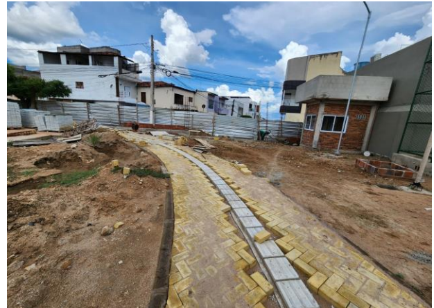
FOTO - 8 INFRAESTRUTURA GERAL - Intertravados (pisos)
