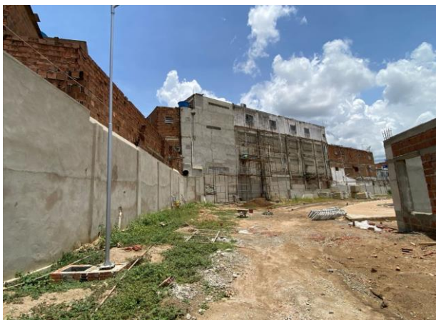
FOTO - 55 DIVERSOS GERAL - Rev., dos muros existentes L.E.
