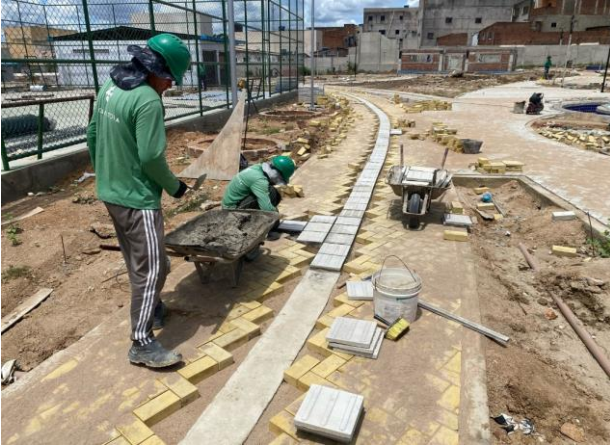
FOTO - 7 INFRAESTRUTURA GERAL - Intertravados (pisos)
