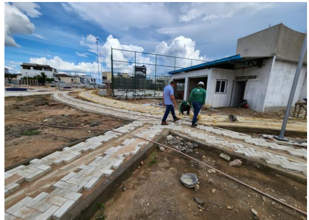
FOTO - 10 INFRAESTRUTURA GERAL - Intertravados (pisos)
