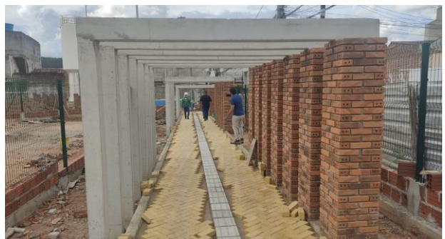
FOTO -6 INFRAESTRUTURA GERAL - Intertravados (pisos)
