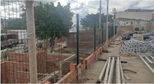
FOTO - 51 DIVERSOS GERAL - Gradil da frente (margens da BR-104)
