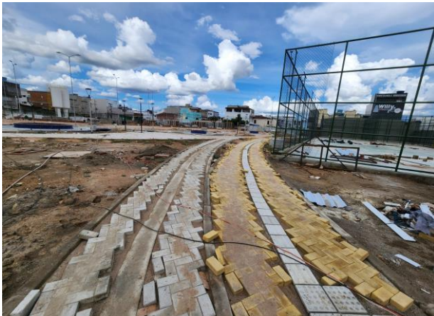
FOTO - 9 INFRAESTRUTURA GERAL - Intertravados (pisos)
