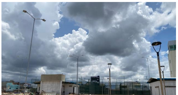
FOTO -4 INFRAESTRUTURA GERAL - Instalações elétrica
