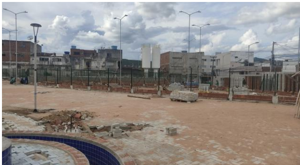
FOTO -3 INFRAESTRUTURA GERAL - Instalações elétrica
