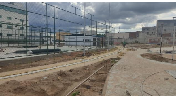
FOTO -5 INFRAESTRUTURA GERAL - Intertravados (pisos)
