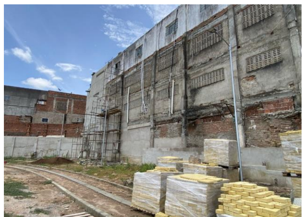
FOTO - 56 DIVERSOS GERAL - Rev., dos muros existentes L.E.
