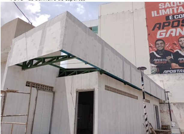
FOTO - 17 Banheiro da área de piquenique
