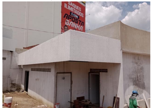
FOTO - 16 Banheiro da área de piquenique
