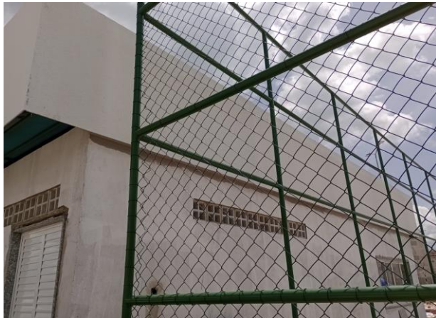
FOTO - 15 Banheiro de esportes
