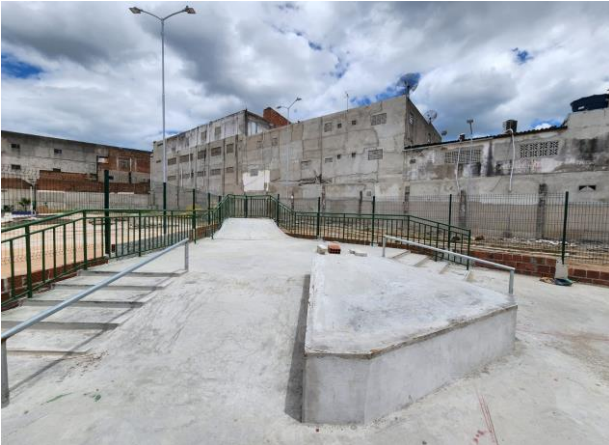
FOTO -1 INFRAESTRUTURA GERAL - Instalações elétrica
