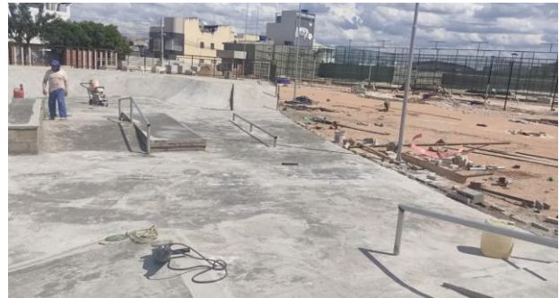
FOTO - 8 Área de Skate (concreto dos pisos e rampas)
