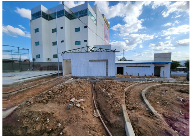
FOTO -6 INFRAESTRUTURA GERAL - Instalações Hidráulica geral
