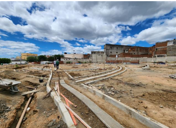
FOTO -5 INFRAESTRUTURA GERAL - Instalações Hidráulica geral
