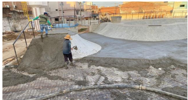
FOTO - 10 Área de Skate (concreto dos pisos e rampas)
