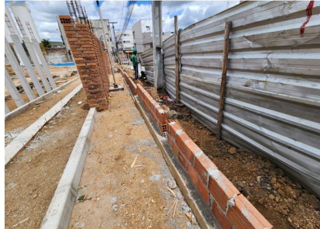
FOTO - 44 Mureta de fechamento (Rua Jerônimo Selestino)
