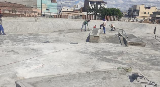
FOTO - 7 Área de Skate (concreto dos pisos e rampas)
