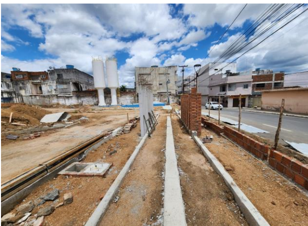
FOTO - 41 Mureta de fechamento (Rua Jerônimo Selestino)
