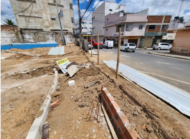
FOTO - 43 Mureta de fechamento (Rua Jerônimo Selestino)
