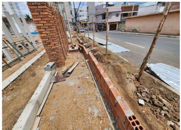
FOTO - 42 Mureta de fechamento (Rua Jerônimo Selestino)
