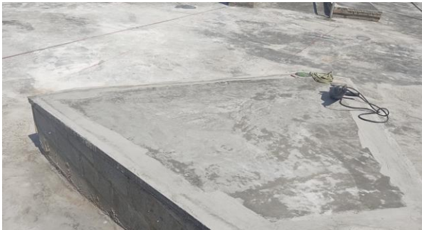
FOTO - 9 Área de Skate (concreto dos pisos e rampas)
