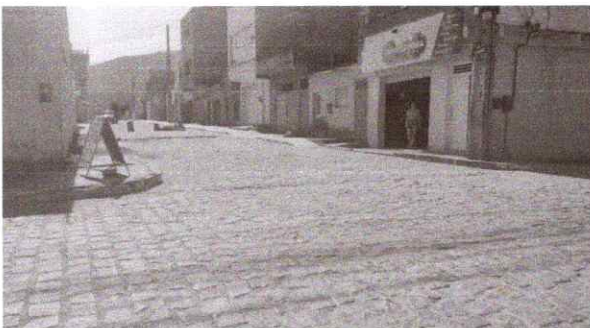
FOTO-05 - Pavimento da Rua Everaldo Guedes
