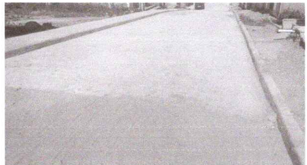
FOTO-02 - Pavimento da Rua Everaldo Guedes
