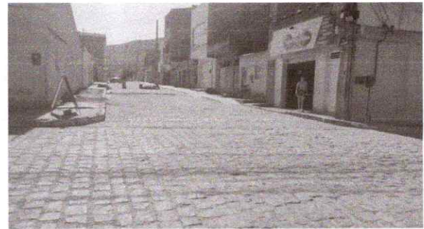
FOTO-06 - Pavimento da Rua Everaldo Guedes
