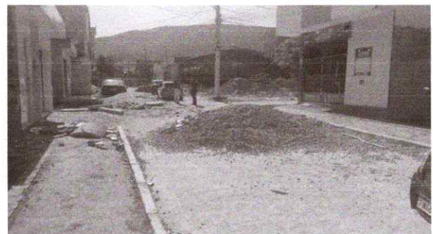
FOTO-04 - Pavimento da Rua Everaldo Guedes
