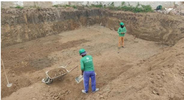
FOTO - 27 Preparo do fundo do reservatório d' água inferior para receber o concreto magro conforme projeto.
