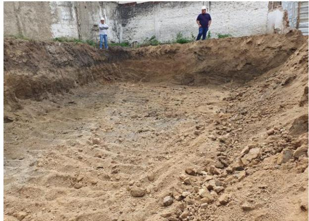
FOTO - 26 Escavação do reservatório d' água inferior
