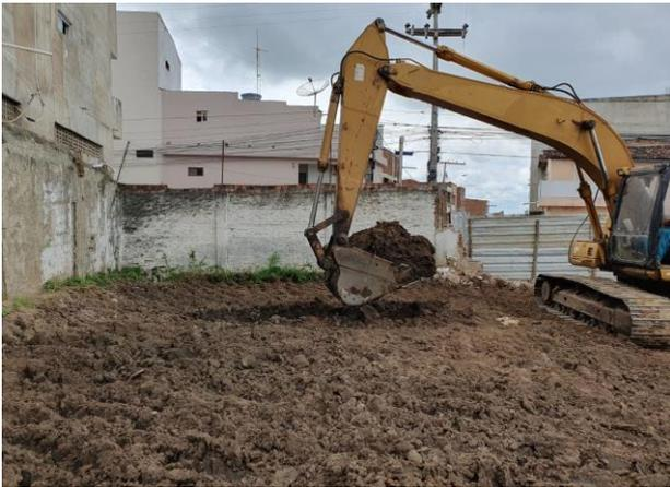
FOTO - 25 Escavação do reservatório d' água inferior
