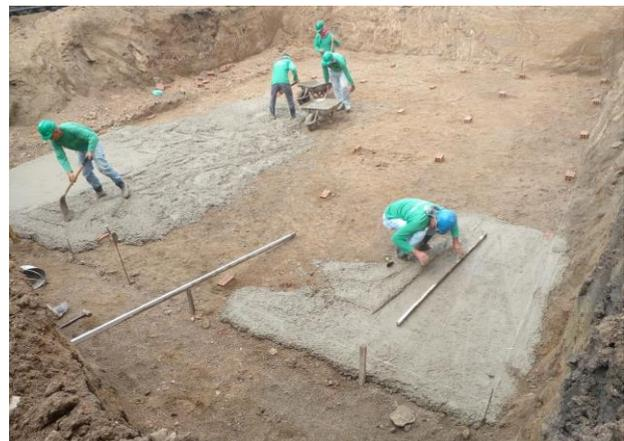
FOTO - 30 Lançamento do concreto magro no fundo do reservatório d' água inferior conforme projeto.
