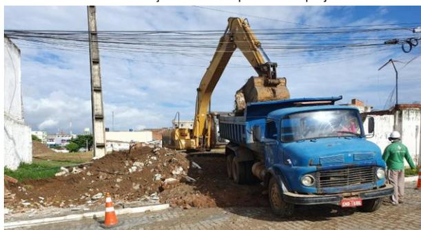
FOTO -7 Carga e transporte do material de demolição
