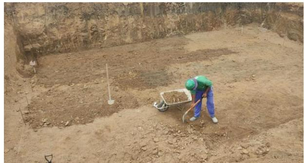
FOTO - 28 Preparo do fundo do reservatório d' água inferior para receber o concreto magro conforme projeto.
