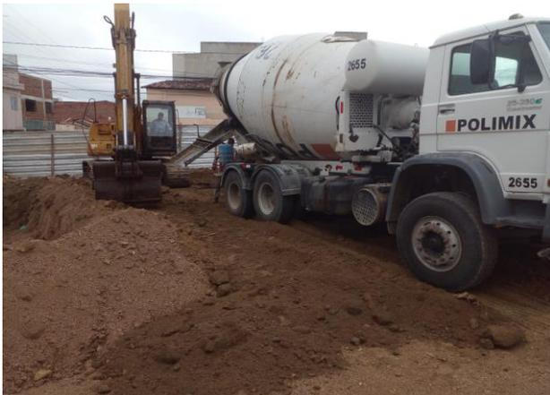
FOTO - 29 Lançamento do concreto magro no fundo do reservatório d' água inferior conforme projeto.
