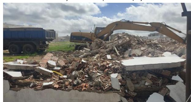
FOTO -8 Carga e transporte do material de demolição
