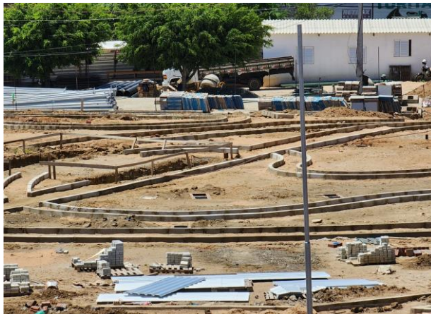
FOTO - 21 Infraestrutura Geral - Meio fio
