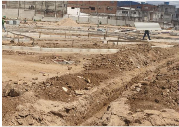
FOTO - 14 Infraestrutura Geral - Escavação de valas
