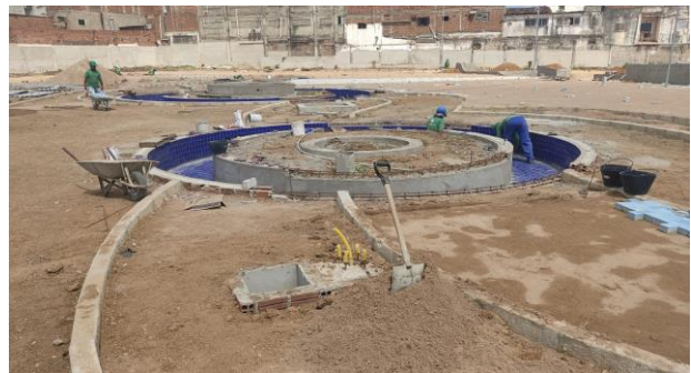
FOTO - 10 Infraestrutura Geral - Caixa de elétrica
