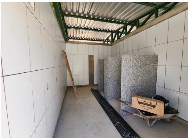
FOTO - 41 Banheiro de esportes
