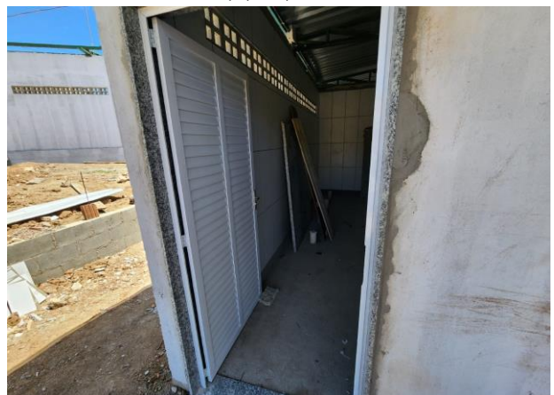
FOTO - 48 Banheiro da área de piquenique
