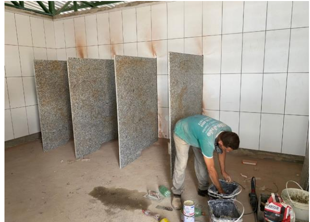
FOTO - 50 Banheiro da área de piquenique
