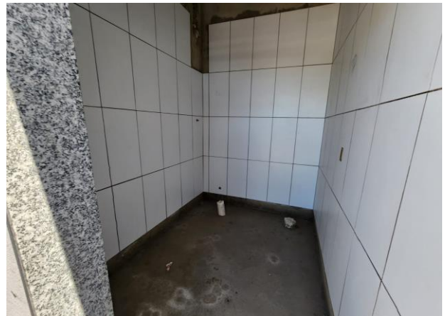
FOTO - 40 Banheiro de esportes
