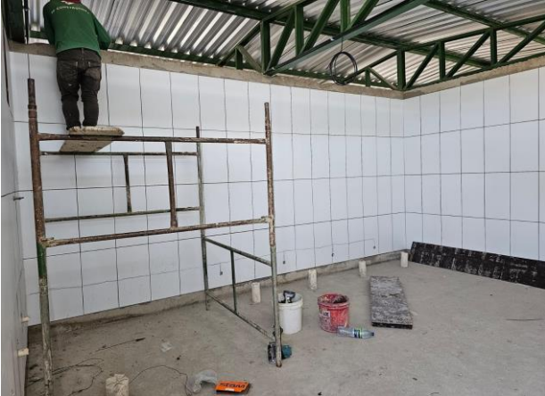
FOTO - 43 Banheiro da área de piquenique
