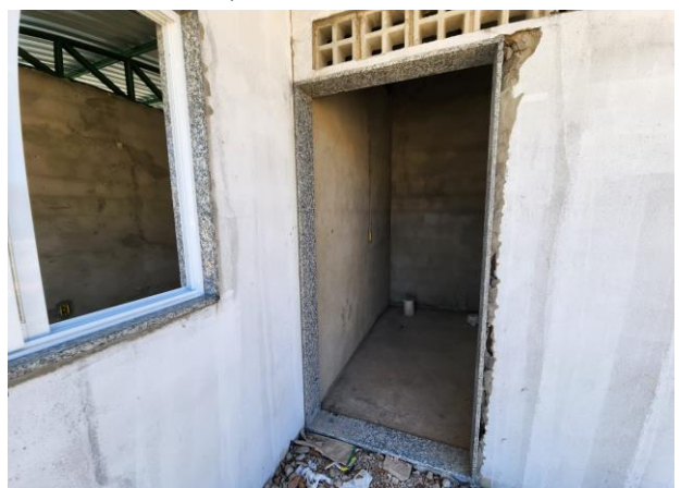
FOTO - 42 Banheiro de esportes
