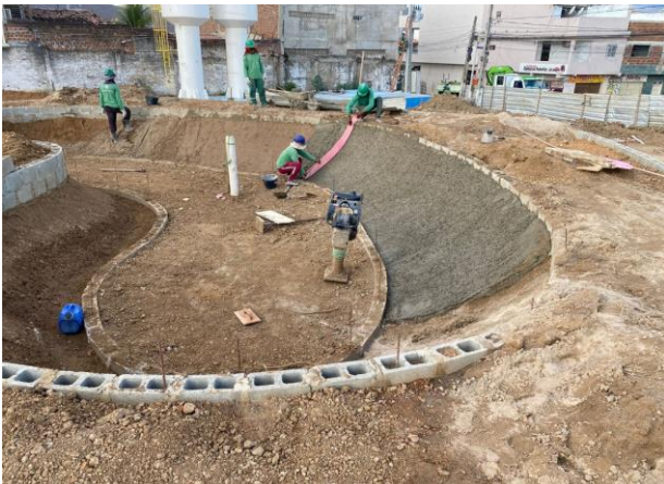
FOTO - 27 Área de Skate (drenagem)
