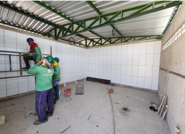
FOTO - 45 Banheiro da área de piquenique
