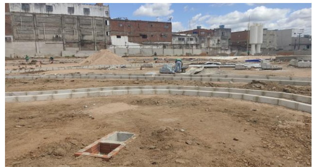
FOTO - 18 Infraestrutura Geral - Meio fio
