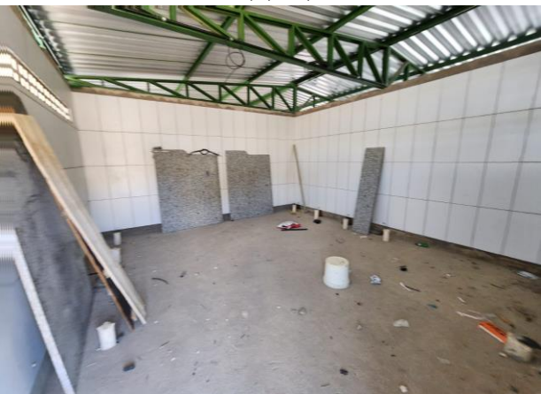
FOTO - 47 Banheiro da área de piquenique
