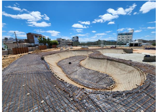
FOTO - 26 Área de Skate (compactação/lona/tela de aço)
