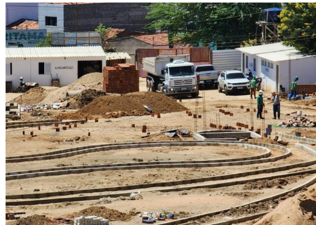
FOTO - 22 Infraestrutura Geral - Meio fio
