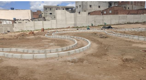
FOTO - 17 Infraestrutura Geral - Meio fio
