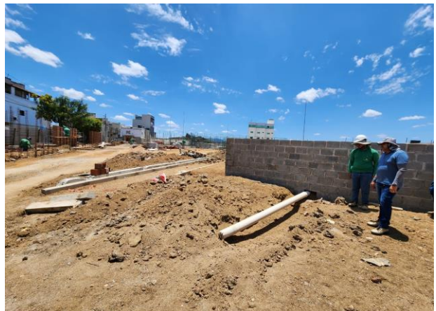
FOTO - 28 Área de Skate (drenagem)
