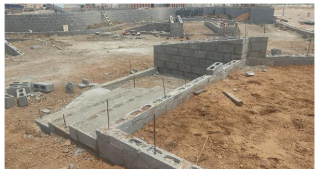
FOTO - 24 Área de Skate (alvenaria/concreto)
