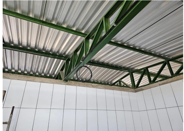
FOTO - 44 Banheiro da área de piquenique
