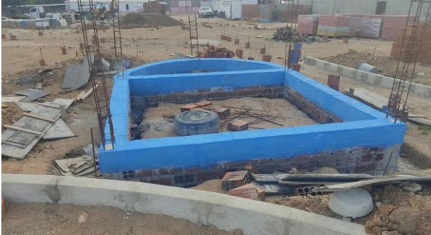
FOTO - 55 Cabine de Som
