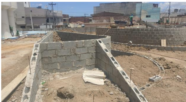
FOTO - 23 Área de Skate (alvenaria/concreto)
