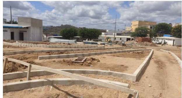
FOTO - 20 Infraestrutura Geral - Meio fio
