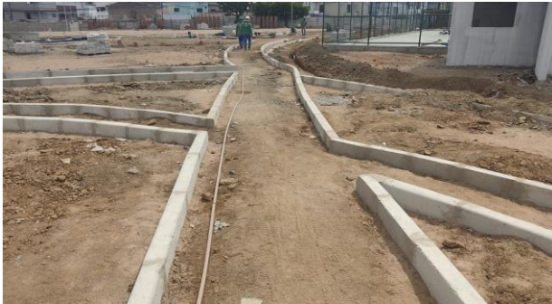
FOTO - 19 Infraestrutura Geral - Meio fio
