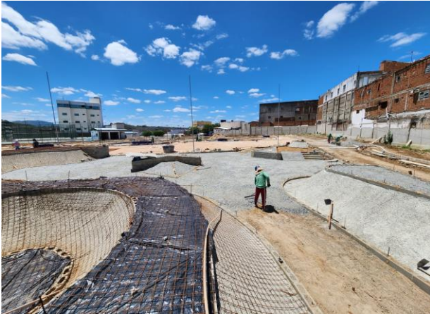
FOTO - 25 Área de Skate (compactação/lona/tela de aço)
