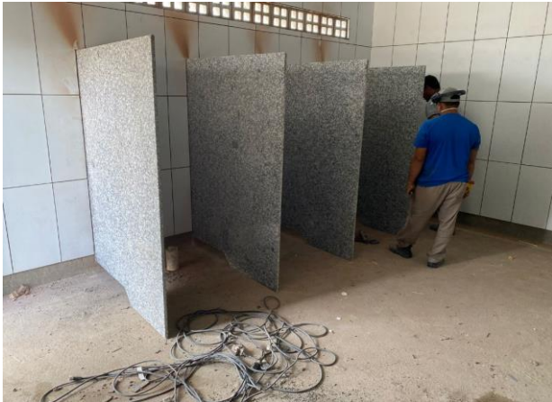
FOTO - 49 Banheiro da área de piquenique
