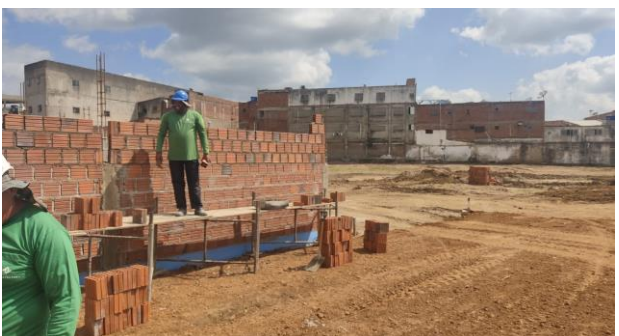
FOTO - 50 Banheiro de Esportes.
