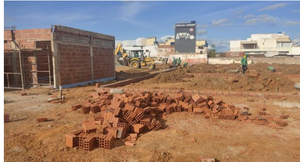
FOTO - 52 Banheiro de Esportes.
