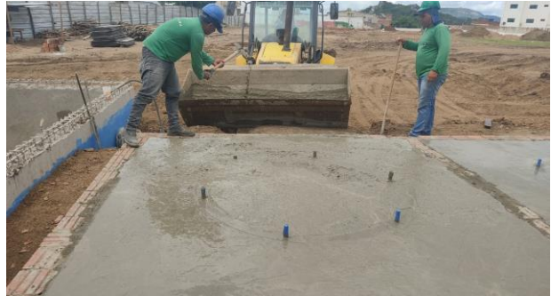
FOTO - 16 Base do Castelo d'água
