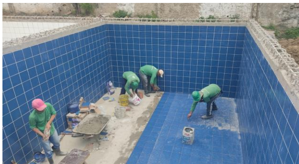
FOTO -7 Impermeabilização e revestimento do reservatório inferior
