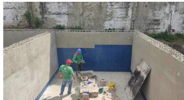
FOTO -6 Impermeabilização e revestimento do reservatório inferior
