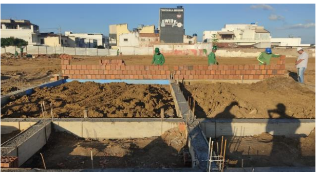
FOTO - 48 Banheiro de Esportes.
