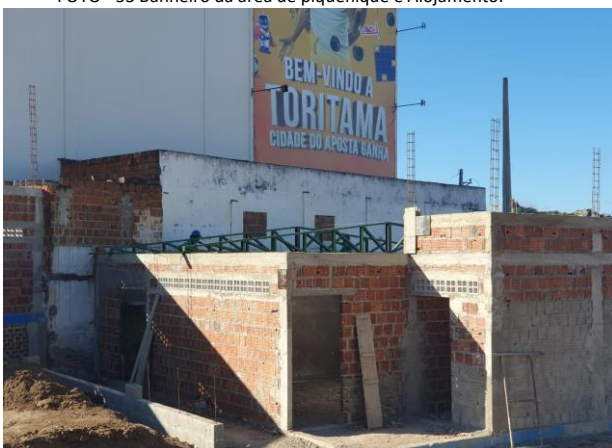
FOTO - 55 Banheiro da área de piquenique e Alojamento.
