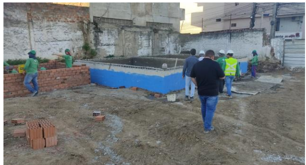
FOTO -4 Impermeabilização e revestimento do reservatório inferior
