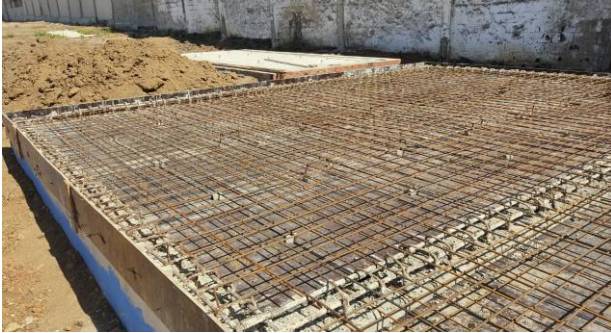
FOTO - 9 Laje de cobertura do reservatório inferior
