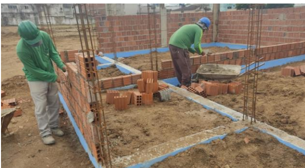
FOTO - 49 Banheiro de Esportes.
