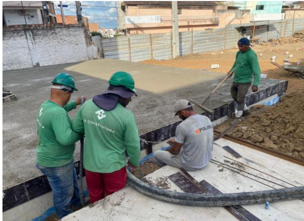
FOTO - 11 Laje de cobertura do reservatório inferior
