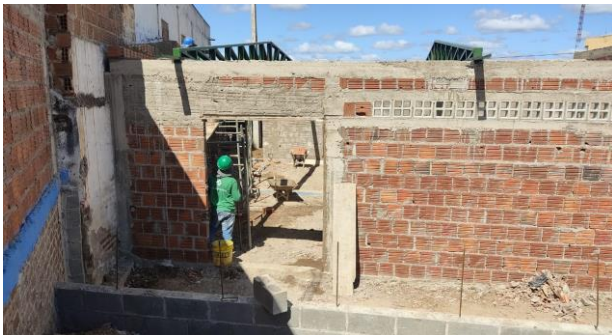
FOTO - 53 Banheiro da área de piquenique e Alojamento.
