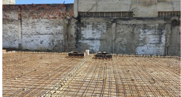
FOTO - 10 Laje de cobertura do reservatório inferior
