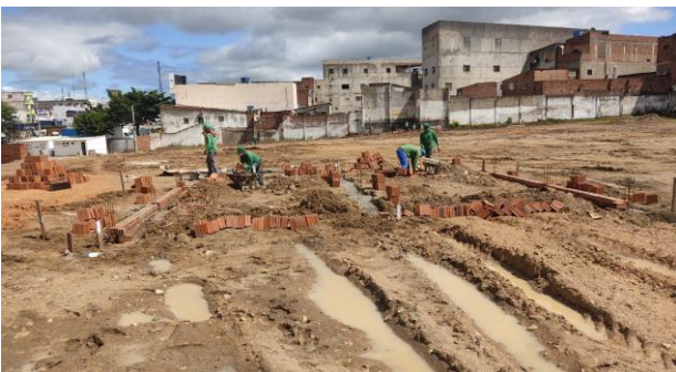
FOTO - 47 Banheiro de Esportes.
