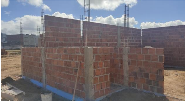
FOTO - 51 Banheiro de Esportes.
