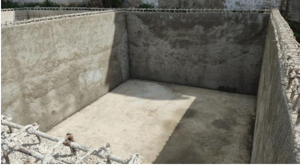
FOTO -1 Impermeabilização e revestimento do reservatório inferior
