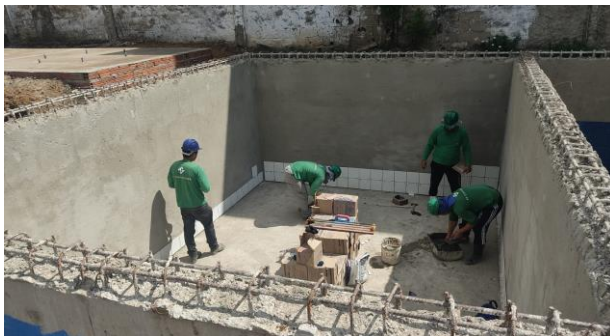
FOTO -5 Impermeabilização e revestimento do reservatório inferior
