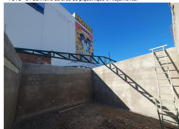
FOTO - 56 Banheiro da área de piquenique e Alojamento.
