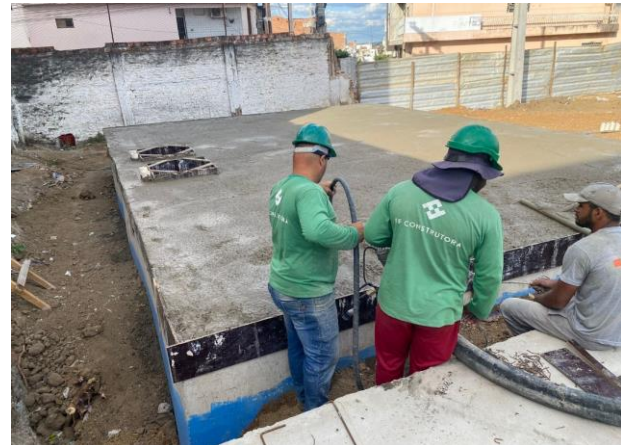
FOTO - 12 Laje de cobertura do reservatório inferior
