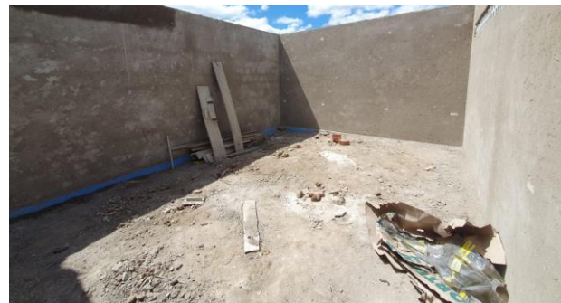
FOTO - 54 Banheiro da área de piquenique e Alojamento.
