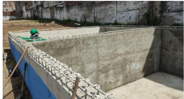
FOTO -2 Impermeabilização e revestimento do reservatório inferior
