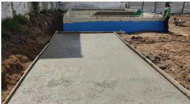
FOTO - 13 Base do Castelo d'água
