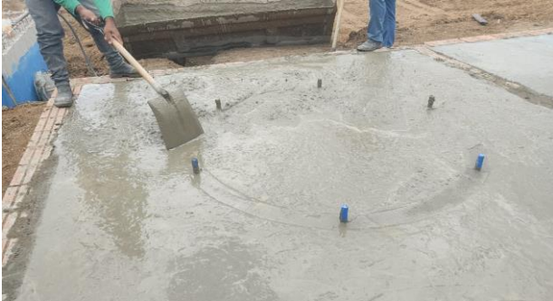
FOTO - 15 Base do Castelo d'água
