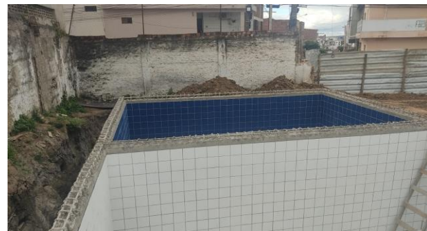
FOTO -8 Impermeabilização e revestimento do reservatório inferior
