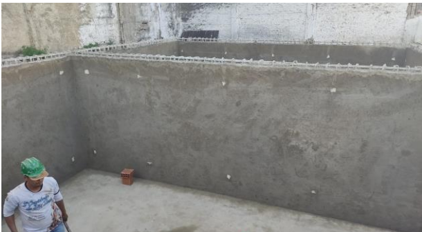
FOTO -3 Impermeabilização e revestimento do reservatório inferior
