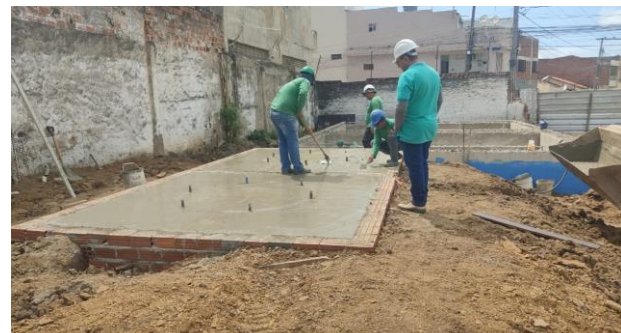
FOTO - 14 Base do Castelo d'água
