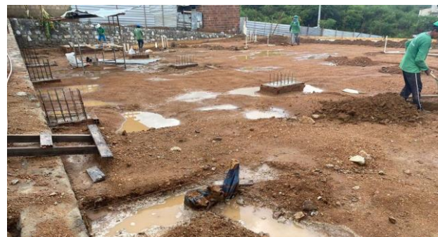
Sapatas/Pilaretes do Bloco C10
