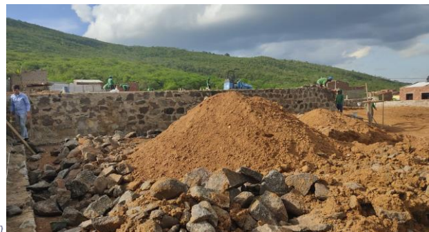
Construção dos muros de contenção (entre o platô 3 e 4)
