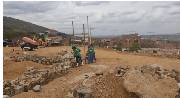
Construção do muro de contenção (Centro - contorno do plato-1)
