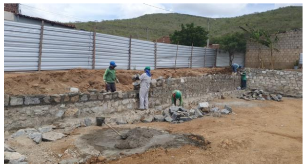
Construção do muro de contenção (Lado esquerdo/fundos)
