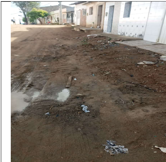
Figura 1 (REMOÇÃO DE SOLO ARGILOSO SATURADO COM RETRO E ATERRO)
