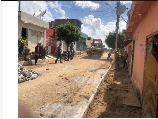
Figura 9 (REMOÇÃO DE SOLO ARGILOSO SATURADO COM RETRO E ATERRO)
