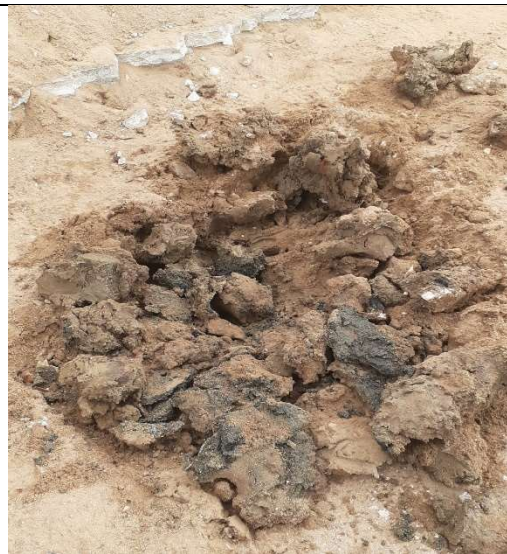
Figura 2 (REMOÇÃO DE SOLO ARGILOSO SATURADO COM RETRO E ATERRO)
