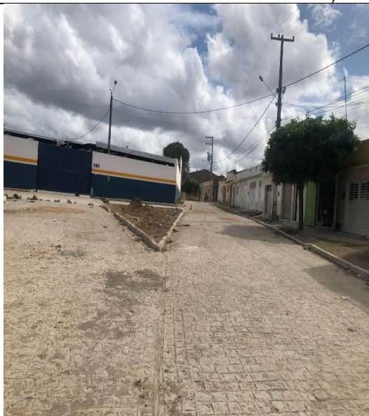
Figura 7 (REMOÇÃO DE SOLO ARGILOSO SATURADO COM RETRO E ATERRO)
