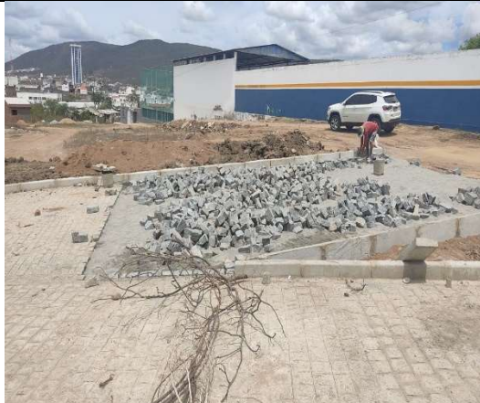
Figura 5 (REMOÇÃO DE SOLO ARGILOSO SATURADO COM RETRO E ATERRO)
