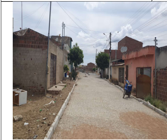
Figura 11 (REMOÇÃO DE SOLO ARGILOSO SATURADO COM RETRO E ATERRO)
