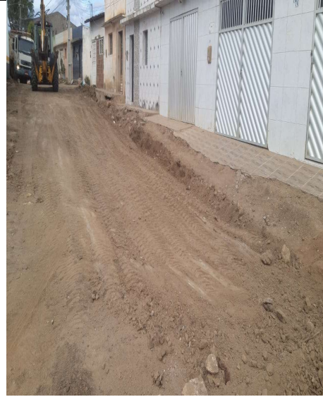
Figura 4 (REMOÇÃO DE SOLO ARGILOSO SATURADO COM RETRO E ATERRO)
