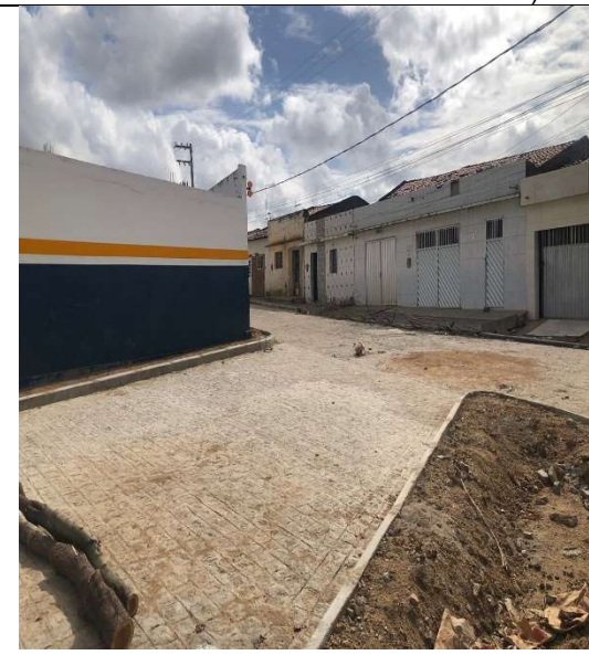
Figura 8 (REMOÇÃO DE SOLO ARGILOSO SATURADO COM RETRO E ATERRO)
