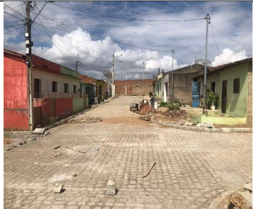
Figura 10 (REMOÇÃO DE SOLO ARGILOSO SATURADO COM RETRO E ATERRO)
