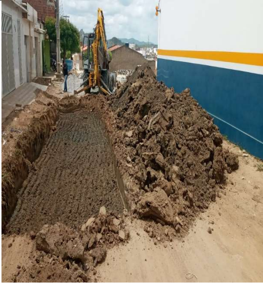
Figura 3 (REMOÇÃO DE SOLO ARGILOSO SATURADO COM RETRO E ATERRO)
