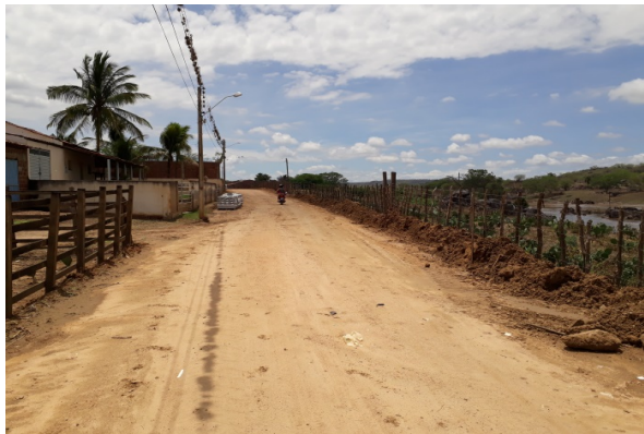
FOTO-7 (ITEM 2.1 - Regularização)
