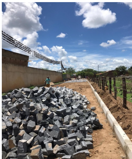
FOTO-12 (ITEM 2.3 - Pavimentação)
