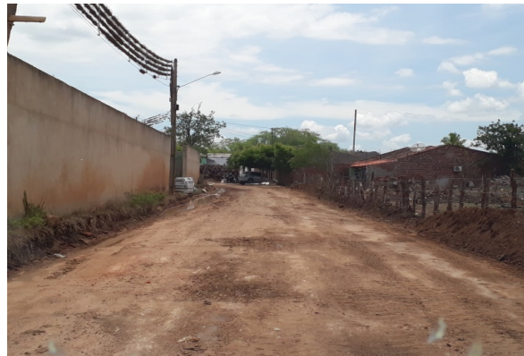
FOTO-8 (ITEM 2.1 - Regularização)
