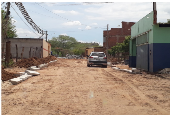
FOTO-9 (ITEM 2.2 - Meio Fio)
