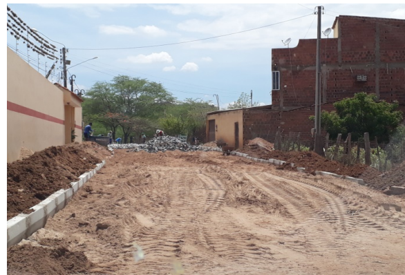
FOTO-10 (ITEM 2.2 - Meio Fio)
