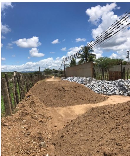
FOTO-11 (ITEM 2.3 - Pavimentação)
