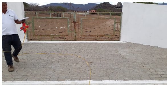
FOTO-3 (Pavimento - ITEM 2.3)
