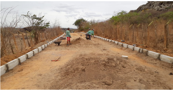
FOTO-1 (Trecho Regularizado - ITEM 2.1)
