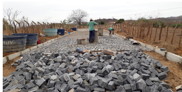
FOTO-4 (Meio fio - ITEM 2.2)
