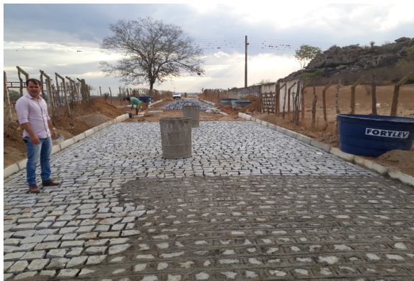
FOTO-3 (seguimento do trecho sentido cidade)
