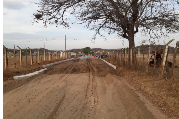
FOTO-2 (Trecho Regularizado - ITEM 2.1)
