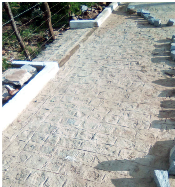
FOTO-10 (ITEM 2.3 - Pavimentação) (ABERTURA PARA DESCIDAS D'ÁGUA AO LONGO DA VIA)
