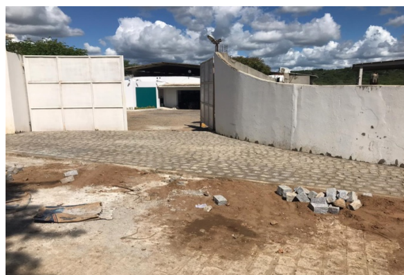
FOTO-8 (ITEM 2.3 - Pavimentação) (ACESSO A LAVANDERIA)
