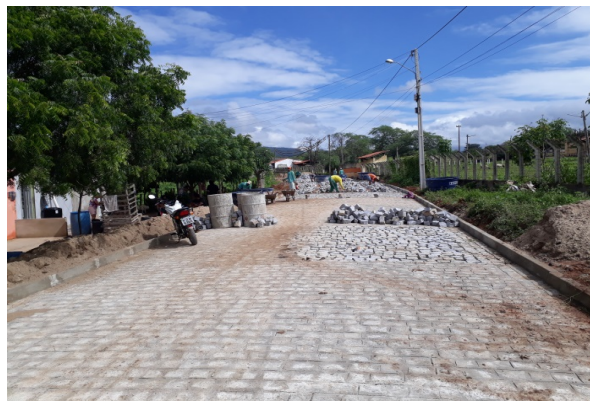
FOTO-3 (ITEM 2.3 - Pavimentação)
