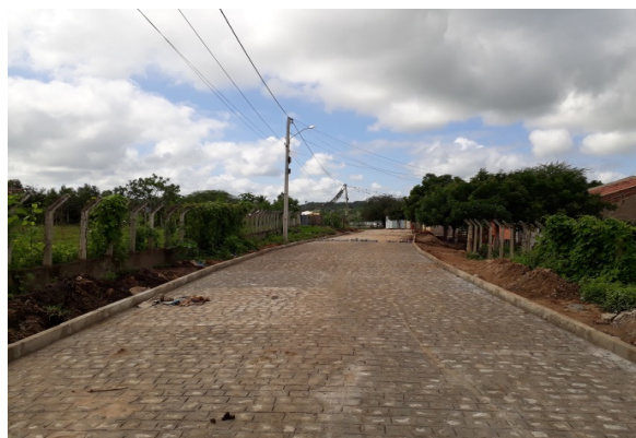
FOTO-4 (ITEM 2.3 - Pavimentação)
