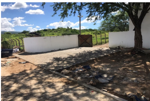
FOTO-9 (ITEM 2.3 - Pavimentação) (ENTRADAS DAS RESIDÊNCIAS AO LONGO DA VIA)
