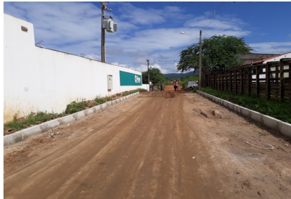
FOTO-2 (ITEM 2.2 - Meio Fio)
