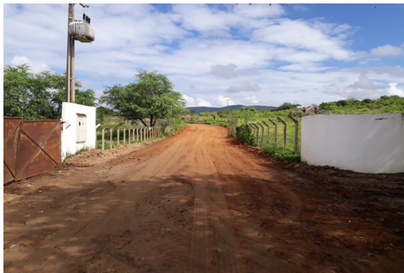
FOTO-1 (ITEM 2.1 - Regularização)
