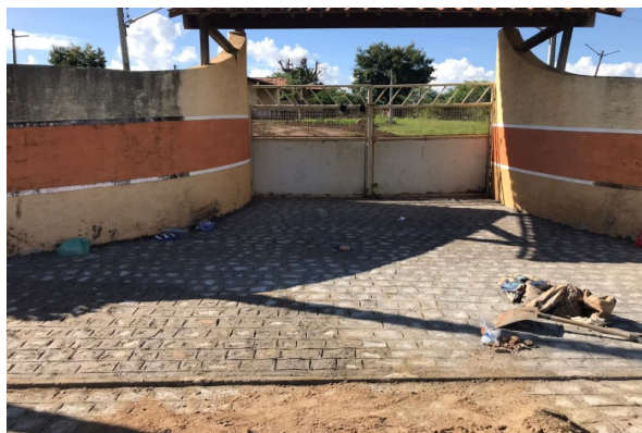
FOTO-7 (ITEM 2.3 - Pavimentação) (ENTRADAS DAS RESIDÊNCIAS AO LONGO DA VIA)
