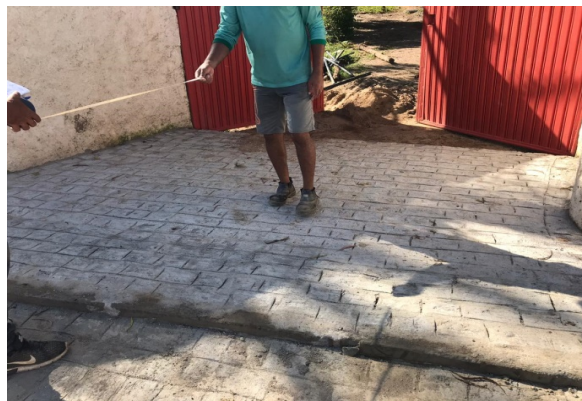
FOTO-6 (ITEM 2.3 - Pavimentação) (ENTRADAS DAS RESIDÊNCIAS AO LONGO DA VIA)
