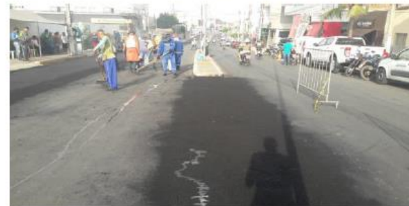
Foto-06 (Complemento das linhas d'água e cruzamento de faixas - Sentido Rua Adalgiza Moura)
