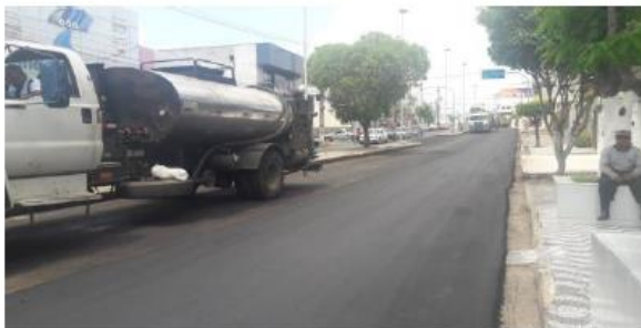
Foto-05 (Conclusão da faixa de rolamento - lado esquerdo - Sentido Rua Adalgiza Moura)
