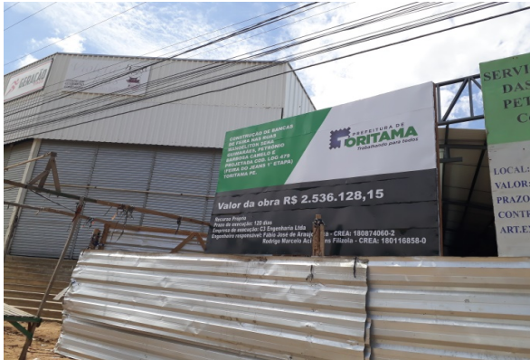
FOTO-1 (Placa da obra)
