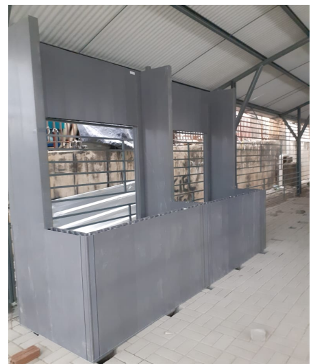
FOTO-5 (Montagem dos Bancos)
