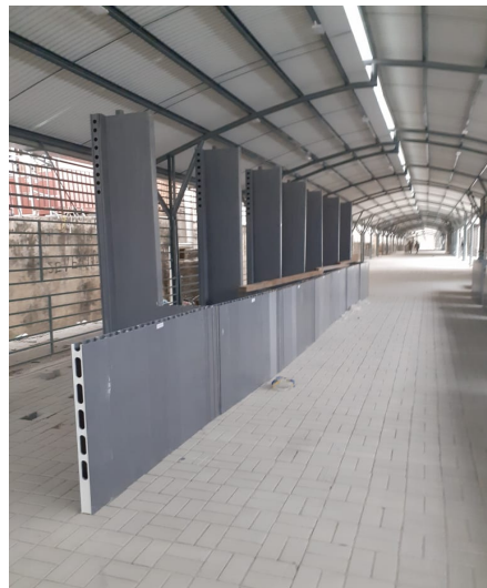
FOTO-4 (Montagem dos Bancos)
