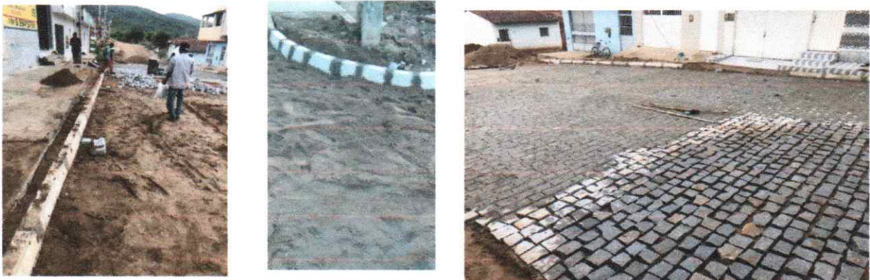
Foto-04/05 (ASSENT MEIO FIO RUA PREF GERSON PEREIRA)
