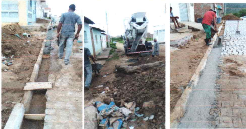
Foto-09/10/11 (EXECUÇÃO DE SARJETA NA RUA PREF GERSON PEREIRA
