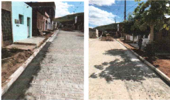
Foto-13/14 (EXECUÇÃO DE SARJETA NA RUA MA SUELI DE SANTANA)
