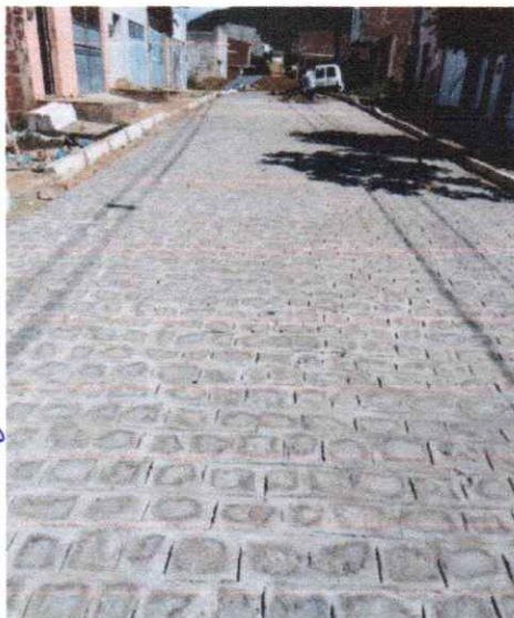
Foto-07/08 (PAVIMENTAÇÃO RUA MA SUELI DE SANTANA)
