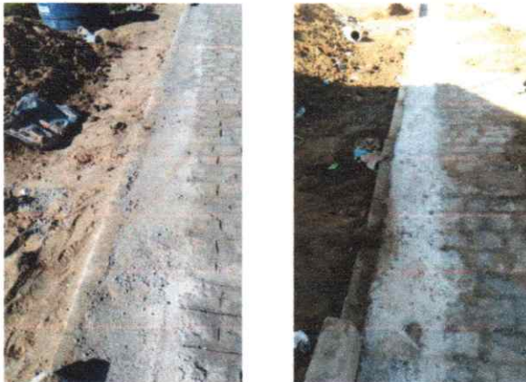
Foto-12/13 (EXECUÇÃO DE SARJETA NA RUA PREF GERSON PEREIRA
