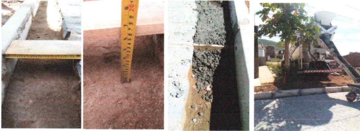
Foto-09/10/11/12 (EXECUÇÃO DE SARJETA NA RUA MA SUELI DE SANTANA)
