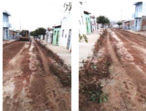
Foto-02/03 (REGUL DE SUPERF RUA MA SUELI)
