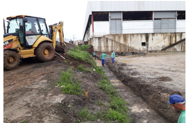
ITEM 2.2.1 (Escavação - MURO DE ARRIMO)
