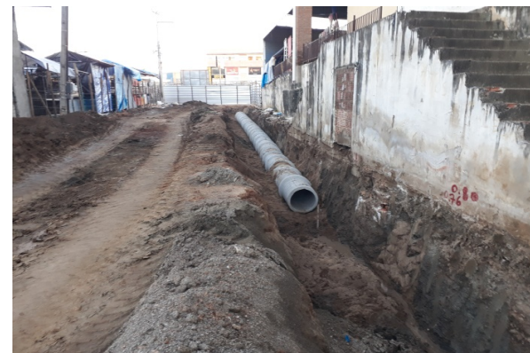
ITEM 2.3.2 (Tubo de Concreto - RUA MANOELITON)
