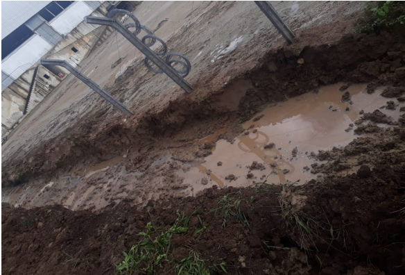
ITEM 2.2.1 (Escavação - MURO DE ARRIMO)
