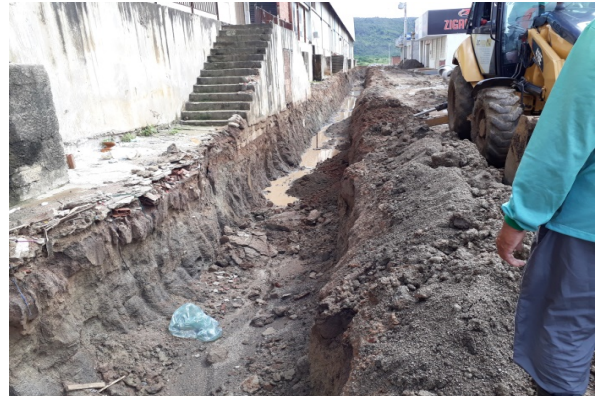
ITEM 2.3.1 (Escavação - RUA MANOELITON)
