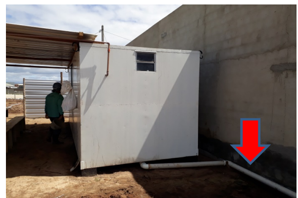
ITEM 1.6 (Inst. Esgoto)
