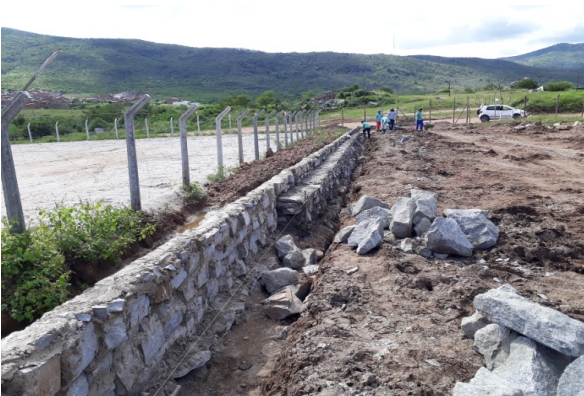
ITEM 2.2.2 (Muro de Arrimo)
