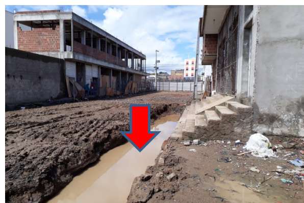
ITEM 1.11 (Retirada de Coletor)
