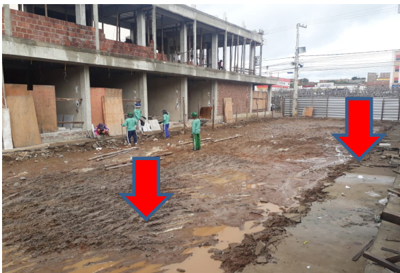
ITENS 1.9 e 1.10 (Demolição - Pavimento e Meio fio)
