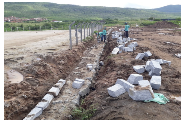
ITEM 2.2.2 (Muro de Arrimo)
