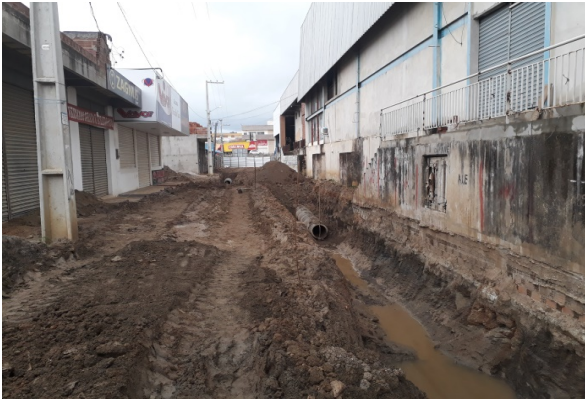
ITEM 2.3.4 (Reaterro - RUA MANOELITON)
