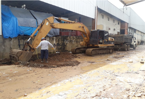
ITEM 2.3.1 (Escavação - RUA MANOELITON)
