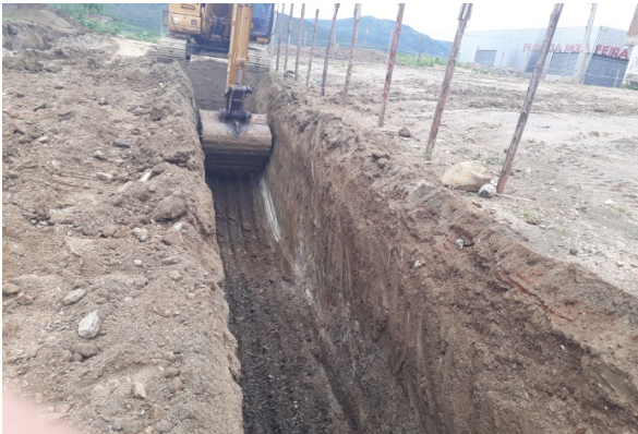
ITEM 2.3.1 (Escavação - RUA PETRÔNIO)
