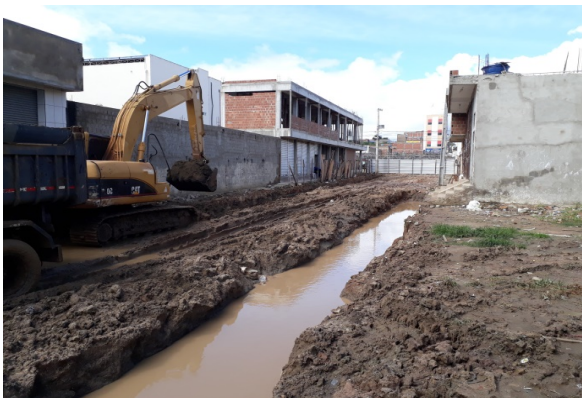
ITEM 2.3.1 (Escavação - RUA PETRÔNIO)
