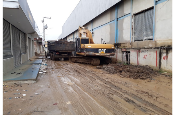
ITEM 2.3.1 (Escavação - RUA MANOELITON)
