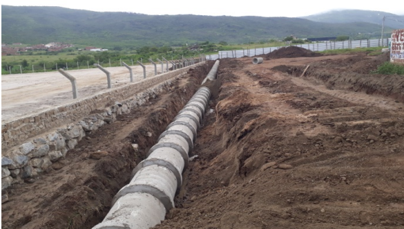
ITEM 2.3.2 (Tubo de Concreto - RUA MANOELITON)
