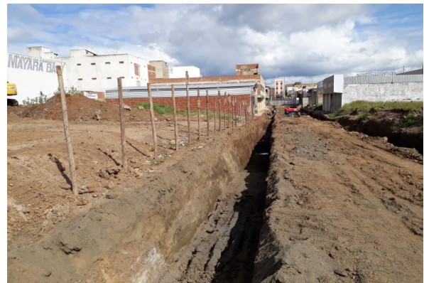
ITEM 2.3.1 (Escavação - RUA PETRÔNIO)
