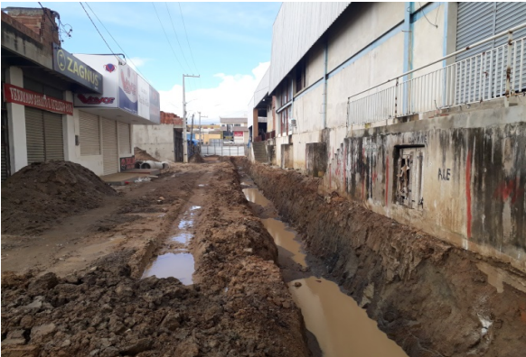
ITEM 2.3.1 (Escavação - RUA MANOELITON)
