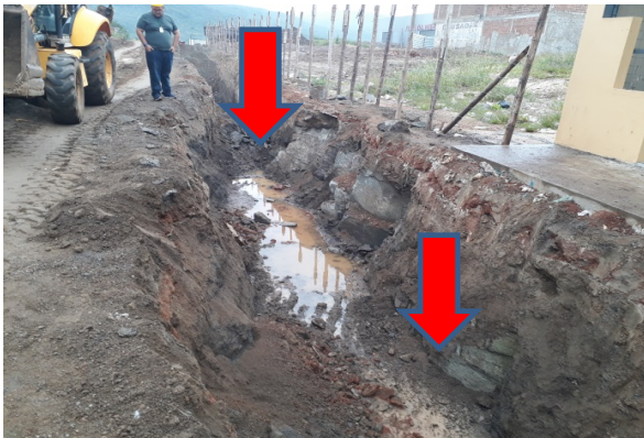
TRECHO DE ROCHAS JÁ RETIRADAS PARA ATINGIR A COTA DA ESCAVAÇÃO DE PROJETO, SERVIÇO À SER ADITADO. RUA PETRÔNIO BARBOSA
