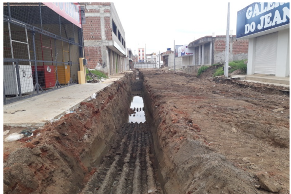
ITEM 2.3.1 (Escavação - RUA PETRÔNIO)
