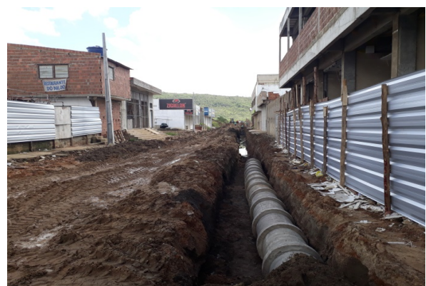
ITEM 2.3.2 (Tubo de Concreto - RUA PETRÔNIO)
