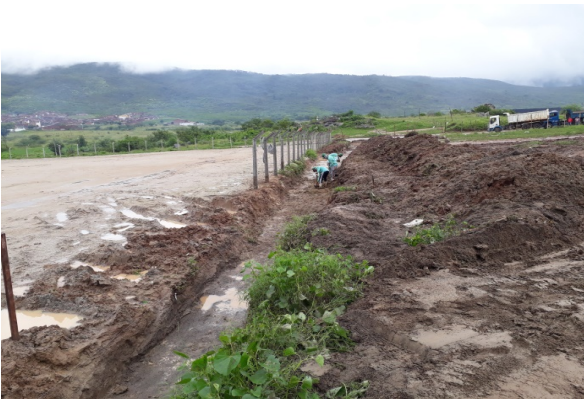
ITEM 2.2.1 (Escavação - MURO DE ARRIMO)
