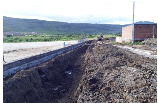
ITENS 2.2.2 e 2.2.3 (Muro de Arrimo e Reaterro)
