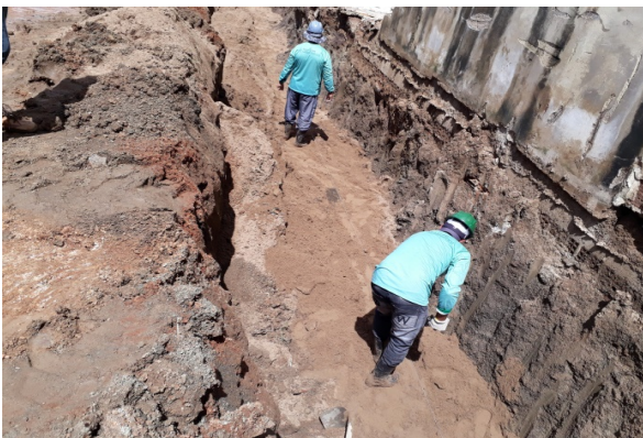
ITEM 2.3.2 (Tubo de Concreto - RUA MANOELITON)
