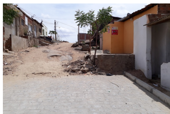
Foto-06 (RUA MANOEL JOAQUIM DE LIMA - Antão) - "Trecho-01"
