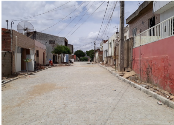
Foto-01 (RUA PROJETADA 01-Valetim-III)
