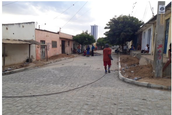
Foto-04 (RUA SEVERINO VALETIM-Valetim-II)
