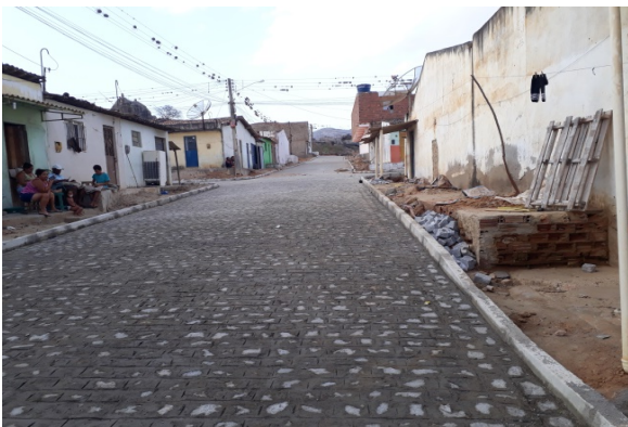
Foto-05 (RUA PROJETADA-05 VALETIM - Valetim-II) - "Trecho-03"
