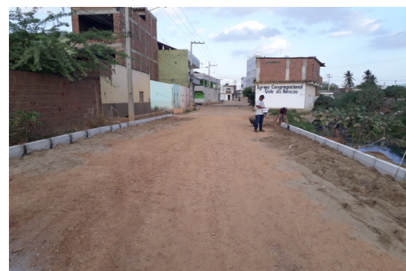
Foto-06 (RUA JOSÉ FERREIRA DA SILVA - Valetim-II) - "Trecho-01"
