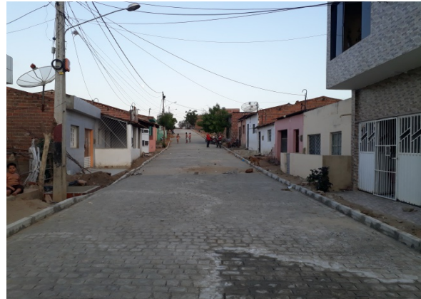
Foto-02 (RUA PROJETADA 01-Valetim-III)
