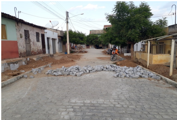
Foto-03 (RUA SEVERINO VALETIM-Valetim-II)
