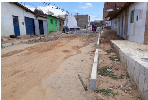
Foto-09 (RUA PROJETADA-05 VALETIM - Valetim-II) - "Trecho-02"
