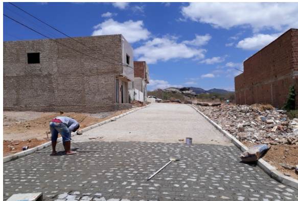
Foto-07 (RUA PROJETADA-05 VALETIM - Valetim-II) - "Trecho-01"
