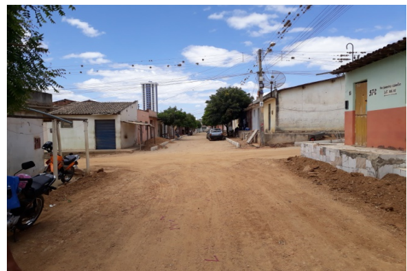
Foto-06 (RUA SEVERINO VALETIM-Valetim-II)
