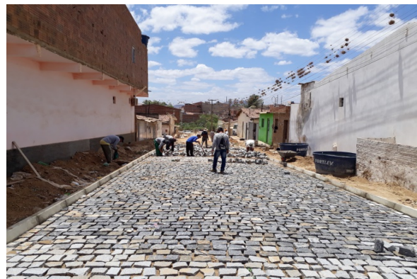
Foto-08 (RUA PROJETADA-05 VALETIM - Valetim-II) - "Trecho-02"
