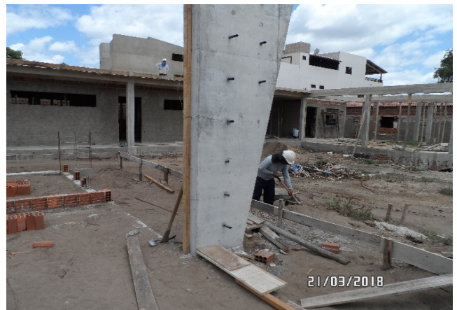
Foto-10 (Pilares Concretado)
