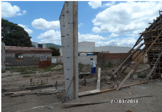
Foto-09 (Pilares Concretado)
