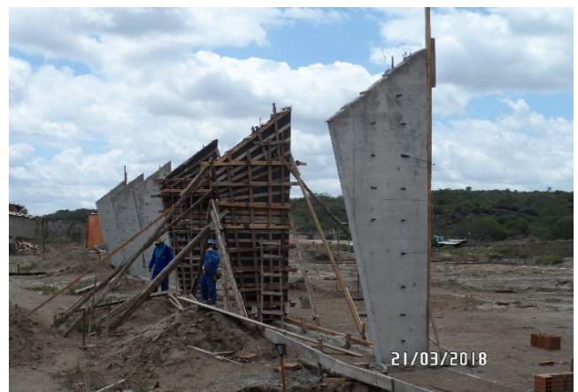
Foto-06 (Pilares: P2 a P7)
