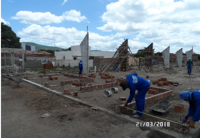
Foto-07 (Aterro do caixão)
