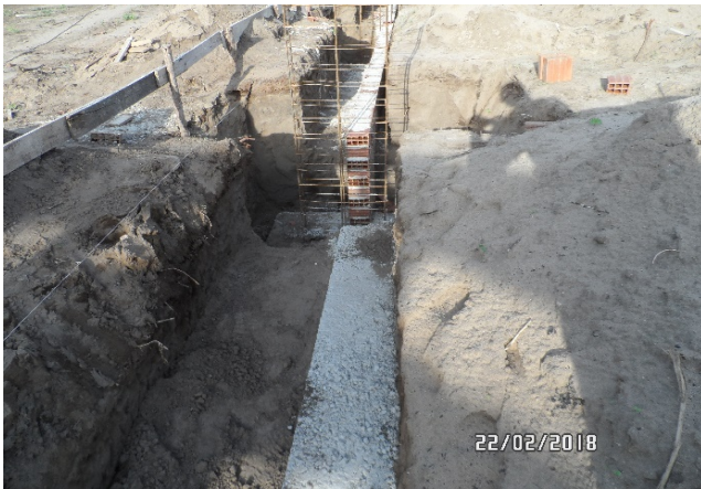
Foto-01 (Concreto Magro)
