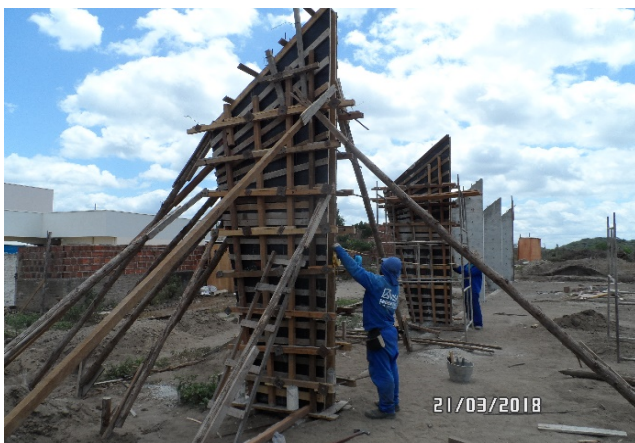
Foto-05 (Forma - Pilares)
