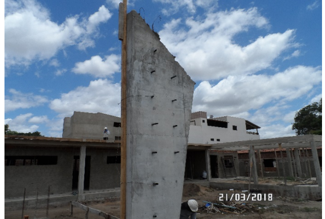
Foto-08 (Pilares Concretado)
