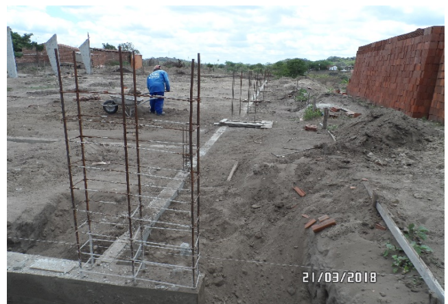
Foto-04 (Vigas Baldrame)
