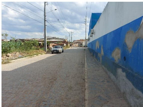
Prolongamento da Rua Manoel Henrique Tavares (Final) – Lavanderia Céu Azul
