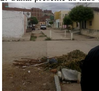
Figura 02: Canal presente ao lado do terreno
