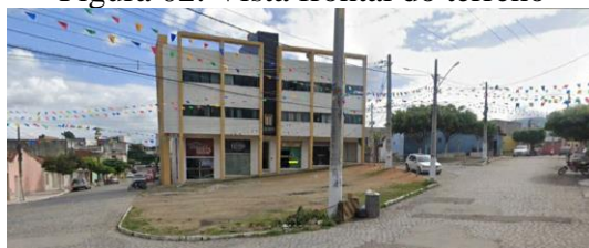
Figura 02: Vista frontal do terreno
