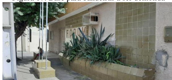
Figura 07: Base para bandeiras a ser demolida
