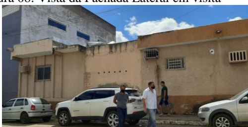
Figura 08: Vista da Fachada Lateral em visita
