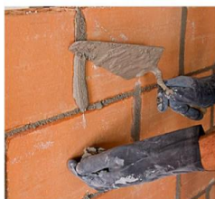
Figura 30: Exemplo de junta amarrada
